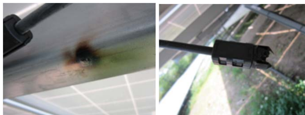
PVケーブルコネクタの損傷
