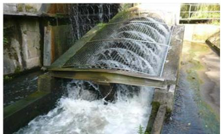
落差が低い水路での発電が可能な「らせん水車」の実証実験。高効率水車の開発により従来では経済性が低く発電が行えなかった地点の活用を推進。
