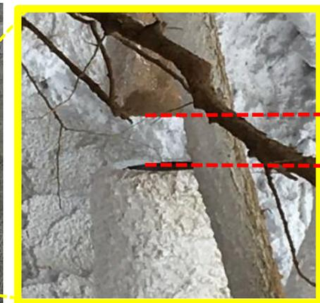
パイプが破断し数インチの隙間が発生
