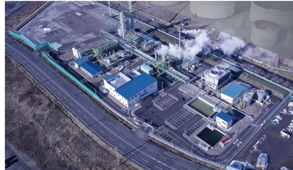
苫小牧CCS実証試験センター
