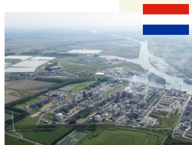
Yara社 【稼働予定】2026年 排出源：肥料アンモニアプラント 貯留量：年間最大80万トン
