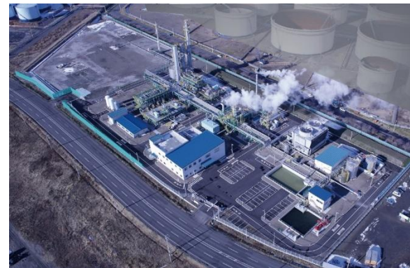
苫小牧CCS実証試験センター
