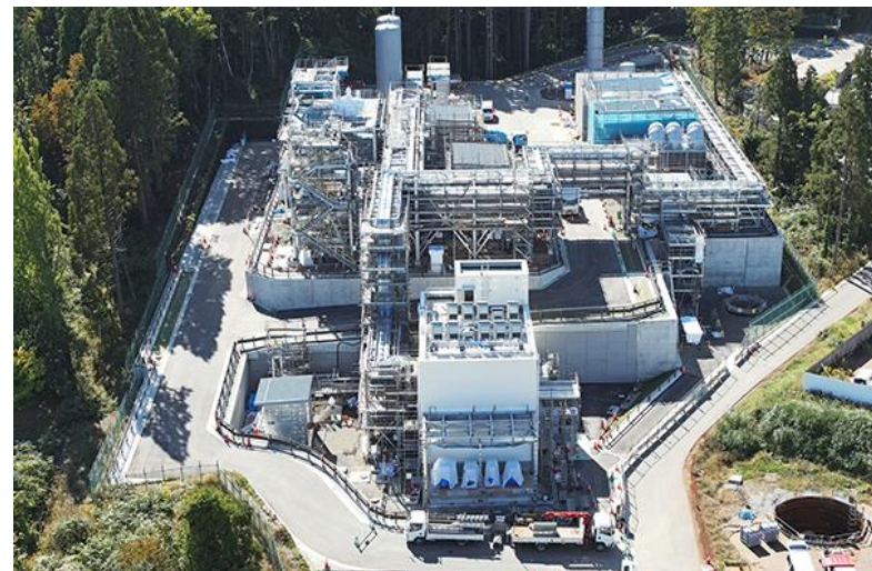
施工中のメタネーション試験設備の外観
