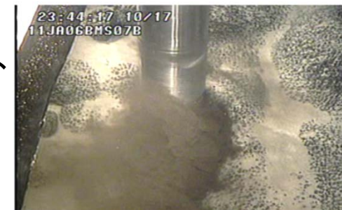
掘削状況(船上モニターからの監視)
