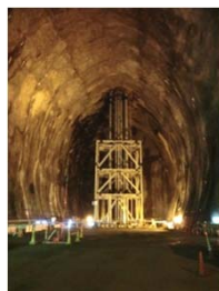
波方基地 (左: 地上設備、右: 地下岩盤貯槽)
