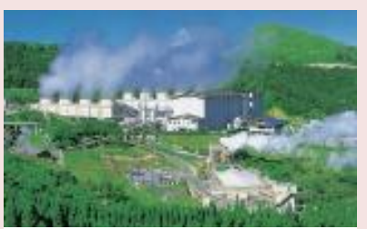
九州電力 八丁原発電所
