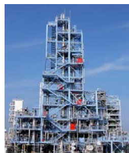
分離回収設備例
