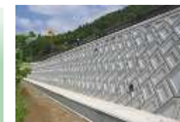
護岸ブロック
