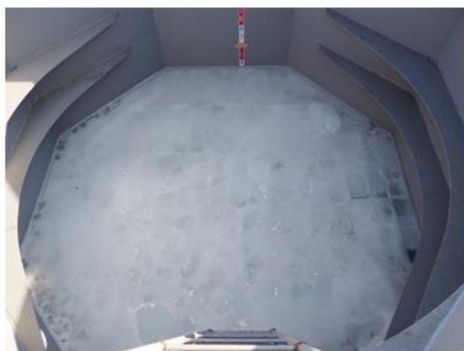
掘削前(タンク内)
