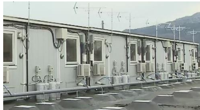
仮設住宅へのLPガス設置
