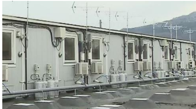
仮設住宅へのLPガス設置
