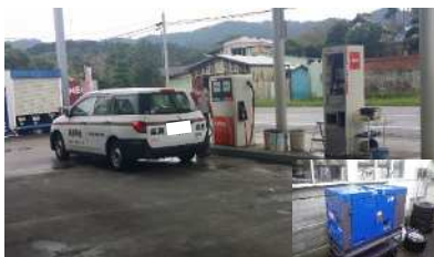
自家発電機を稼働させて、給油を継続したSS(千葉県鴨川市)
