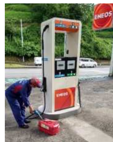
自家発電機を稼働させて給油を継続した 住民拠点SS(大分県九重町)
