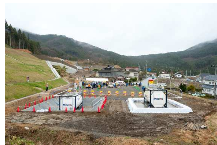
岩手県陸前高田市に開設した仮設SS (2011.4.22撮影)
