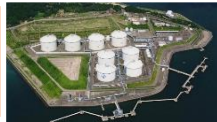
福島国家備蓄基地及び民間隣接基地
