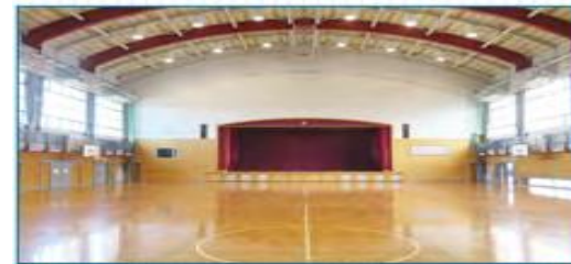
日新小学校屋内運動場での導入事例
