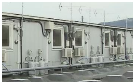
仮設住宅へのLPガス設置
