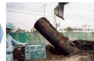
・鋼製一重殻タンクの撤去
