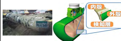
・鋼製一重殻タンクの撤去及び大型二重殻タンクの設置
