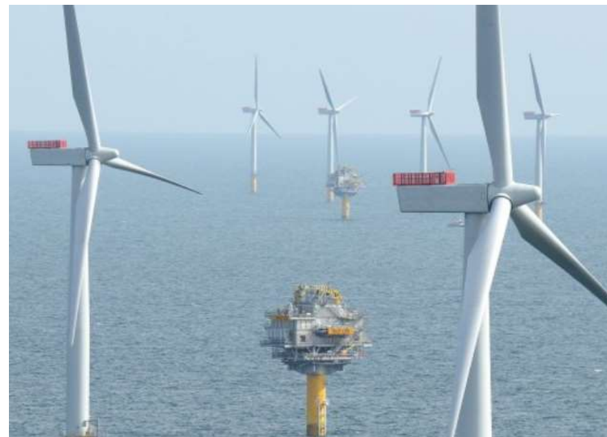
浮体式風力発電設備 (石油ガス生産設備へ直接接続)
