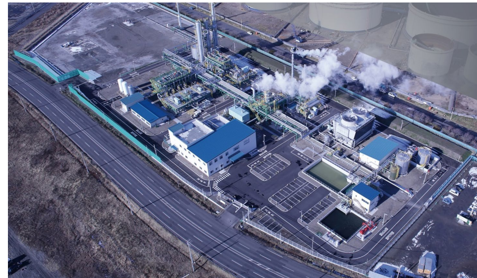
苫小牧CCS実証試験センター
