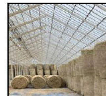
簡易倉庫の設置
