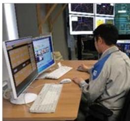
再エネ出力予測及び制御量の見直しをリアルタイムで実施するため、専用操作卓を設置
