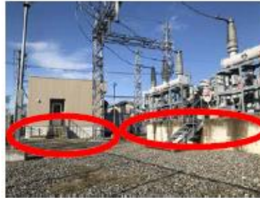
建物および開閉装置の高上げ
