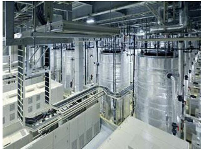
電解液タンク・電力変換装置
