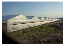
本事業で建設したハウス
