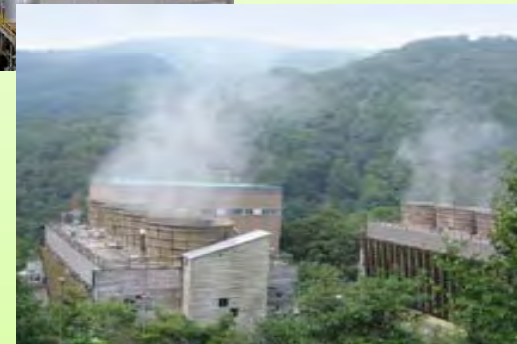
【地熱発電設備】
