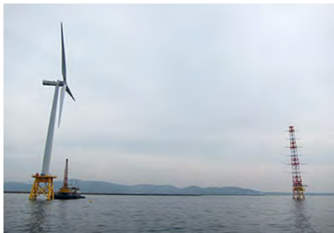
福岡県北九州市沖 (提供:電源開発(株))
