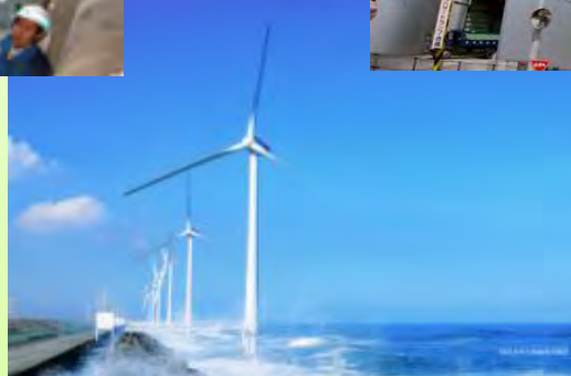
【風力発電設備】
