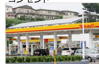
ライフスポット給油所
