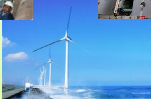
【風力発電設備】
