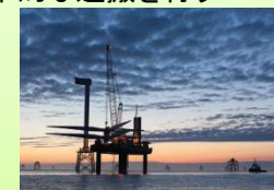
専用船や大型台船1隻で施工(現状、日本は2隻で施工)
