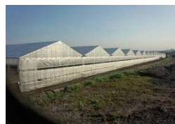
本事業で建設したハウス
