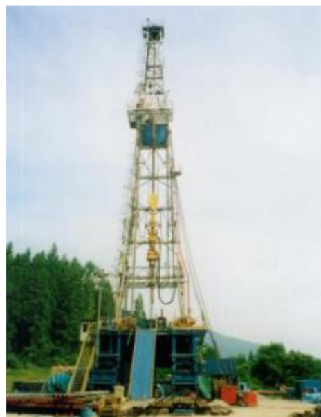
掘削中の110-M掘削機
