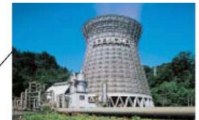
松川地熱発電所 出力 23,500 kW
