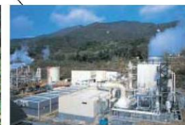
八丈島地熱発電所 出力 3,300 kW
