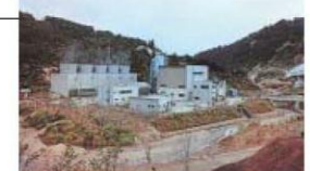
鬼首地熱発電所 出力 12,500 kW
