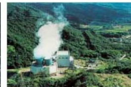
森地熱発電所 出力 50,000 kW
