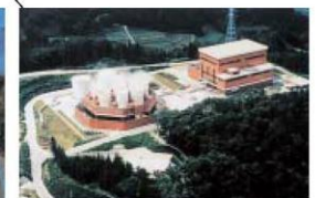
柳津西山地熱発電所 出力 65,000 kW
