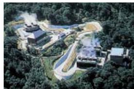
葛根田地熱発電所1・2号 出力 50,000 kW、30,000 kW
