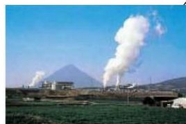
山川地熱発電所 出力 30,000 kW
