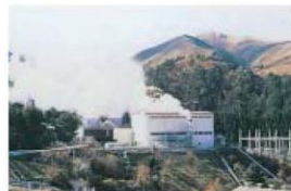
大岳地熱発電所 出力 12,500 kW
