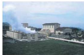
大霧地熱発電所 出力 30,000 kW
