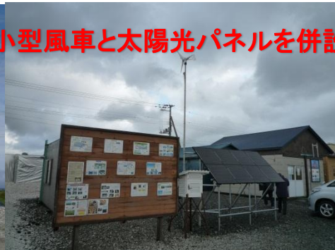
断熱をほどこしたD型ハウス 小型風車と太陽光パネルを併設
