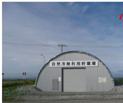
断熱をほどこしたD型ハウス 小型風車と太陽光パネルを併設
