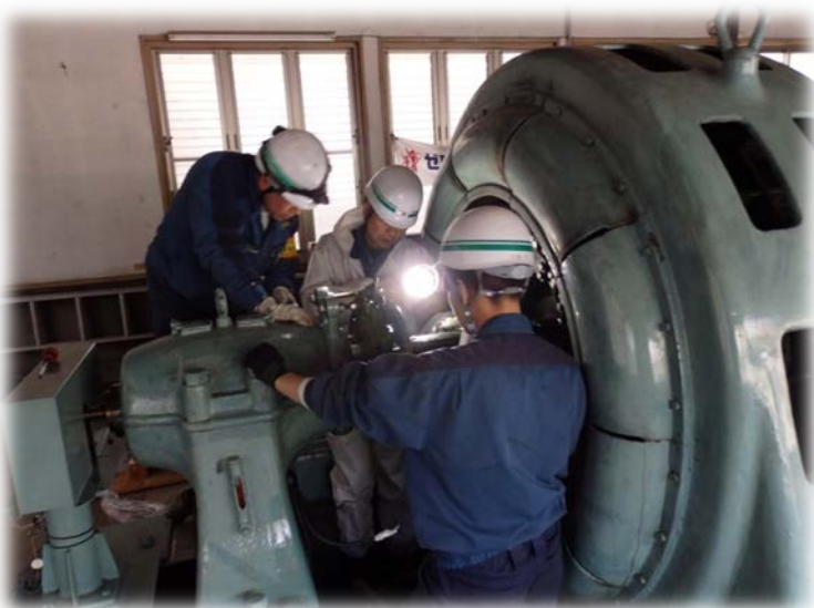
電気設備の巡視・点検状況
