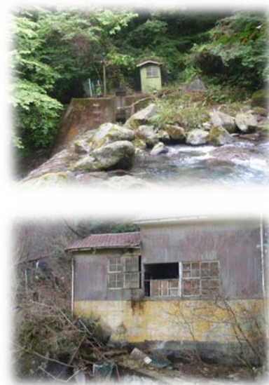
長期期間放置された放置状況(水車発電機・取水えん堤・発電所建物)
