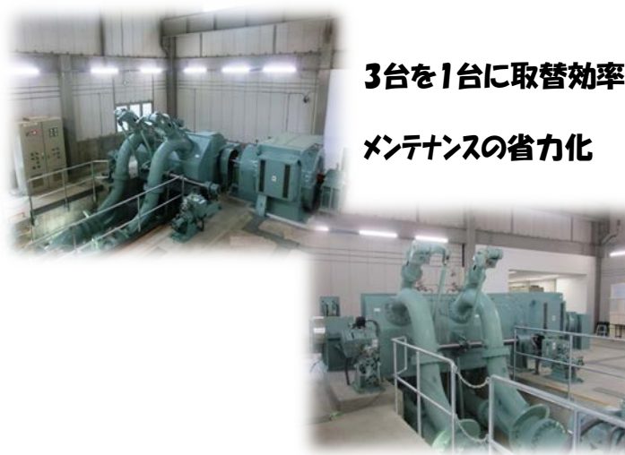
平成27年5月にリプレイスした水車・発電機 3,100kW
