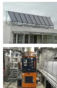
(上)太陽熱集熱器 (下)バイオマスボイラー
