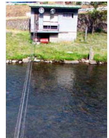
<発電事業者による 流量観測所>
