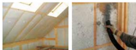
○屋根・床・壁吹き込み断熱(R-工法)
