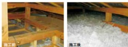
○天井吹き込み断熱
