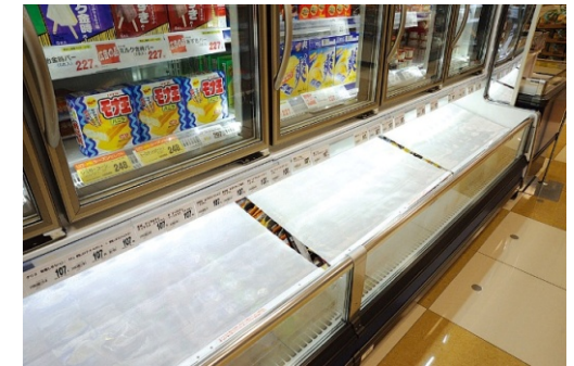
冷蔵機器のナイトシャッター (冷気の漏れを防ぎます)
