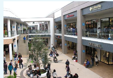
【オープンモール】 共用部の大部分が屋外
