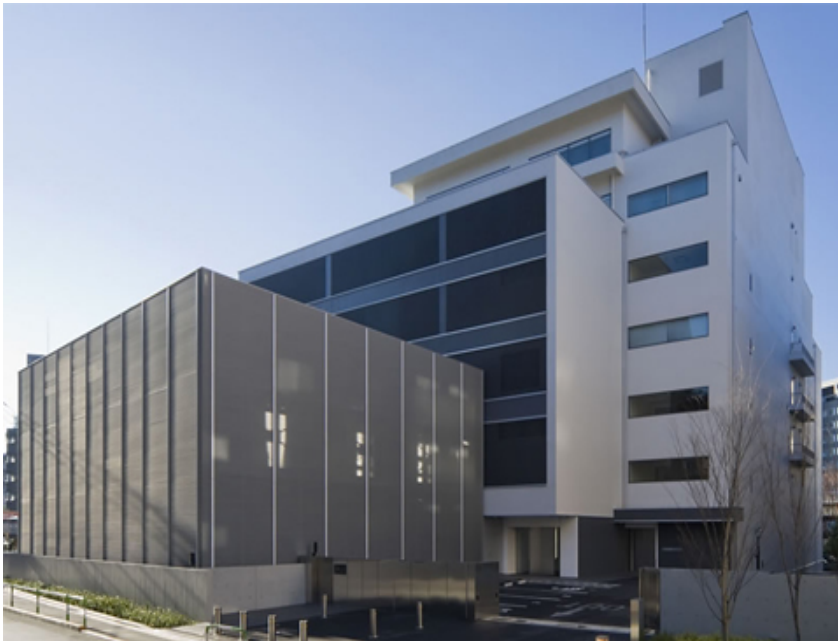
データセンター外観（例）
