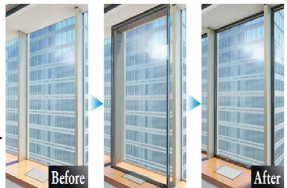
<建築物のリフォーム例:窓の交換>
