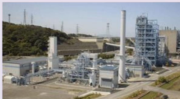
IGCCに最適な高効率CO2回収型石炭ガス化システム
