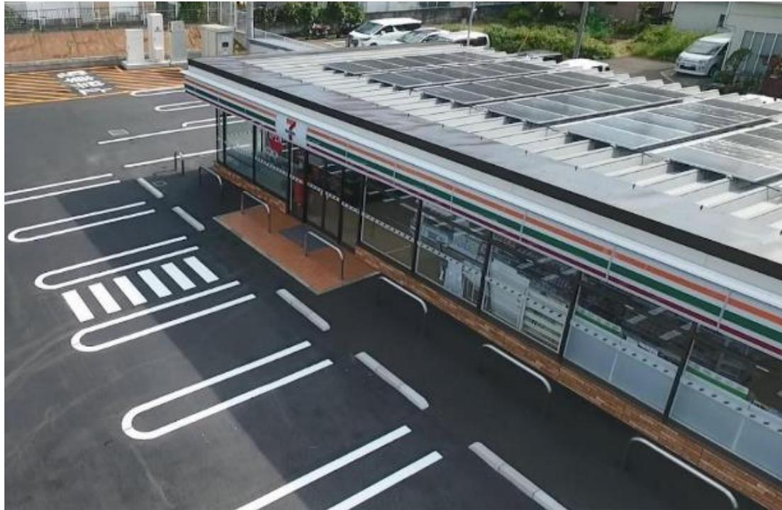
セブン-イレブン・ジャパンによると、2019年の同社標準店舗では、平均して90枚、容量ベースでは28.8kWの太陽光パネルが設置できるとしている。
