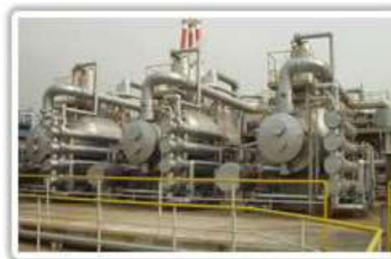
蒸気発生設備
