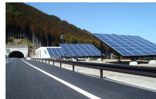
道路を活用した太陽光発電
