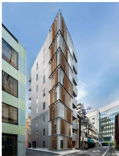
CLTを構造材として採用した6階建以上では国内初の事務所建築「PARK WOOD office iwamotocho」(8階建)
