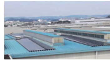
①工場屋根への太陽光パネル設置 （日産自動車追浜工場）
