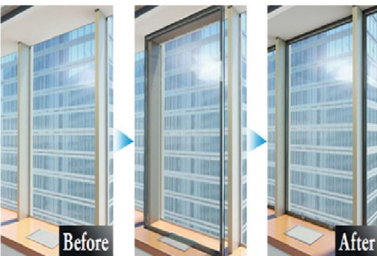
<建築物のリフォーム例: 窓の交換>
