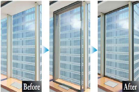
<建築物のリフォーム例: 窓の交換>
