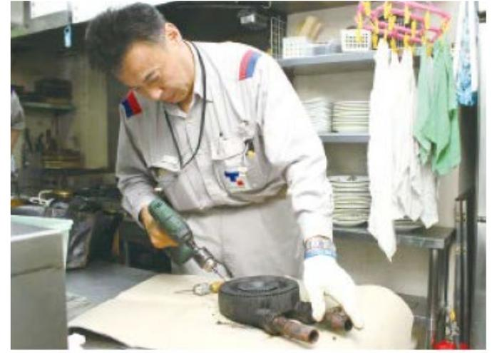
燃焼確認を行った後、燃焼状態を良好にするためにバーナー部を分解し油汚れを取り除く(2019年8月、魚民 四街道北口駅前店様での作業)。
