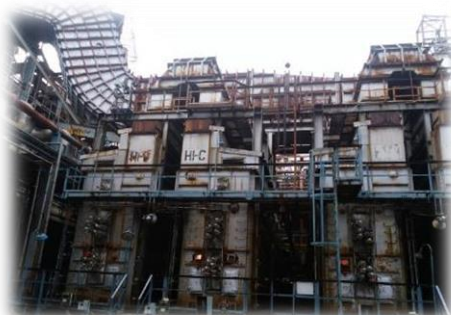
ナフサ分解炉での混焼実証 (一般工業加熱炉)
