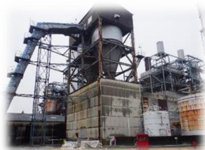
中小型産業用石炭ボイラー での混焼実証
