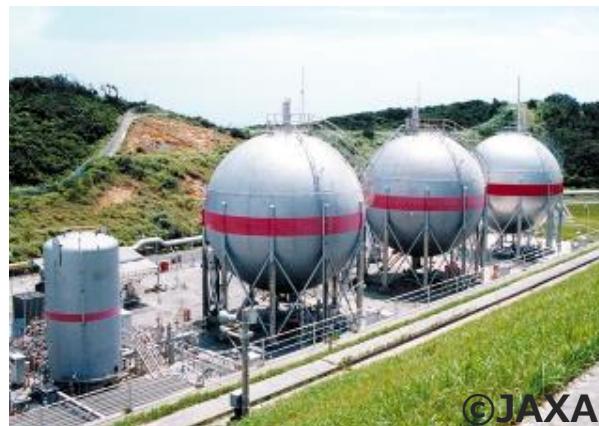
種子島 H-II ロケット基地 （液化水素貯蔵タンク）
