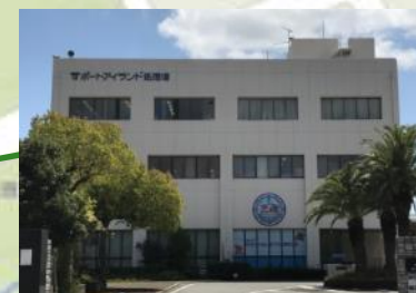
ポートアイランド 処理場
