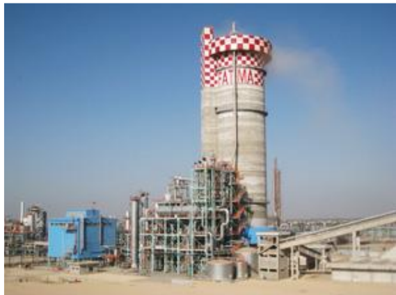
肥料プラント（水素大量製造）
