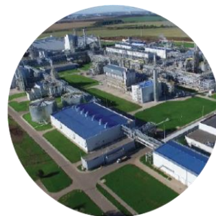
アンモニア・メタノール設備
