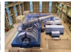
蒸気タービン
