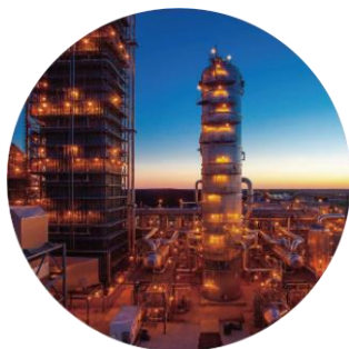
CO 2 回収設備
