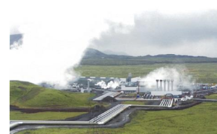
地熱発電プラント
