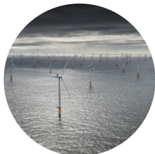
洋上風力発電設備
