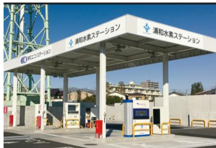
＜浦和水素ステーション＞
